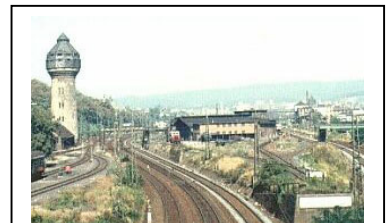
Abb. 6: Ehem. BW Wiesbaden mit zwischenzeitlich abgeris- senem Wasserturm und Ring- lokschuppen
